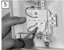
Öffnen Sie die Leuchte wie unter Punkt 1 beschrieben und entfernen die Optik-Halteplatte durch Lösen der rückseitigen Befestigungsschrauben.
